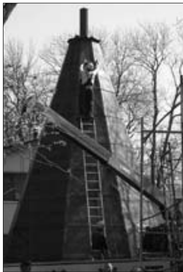
Идет подготовка основания для купола
