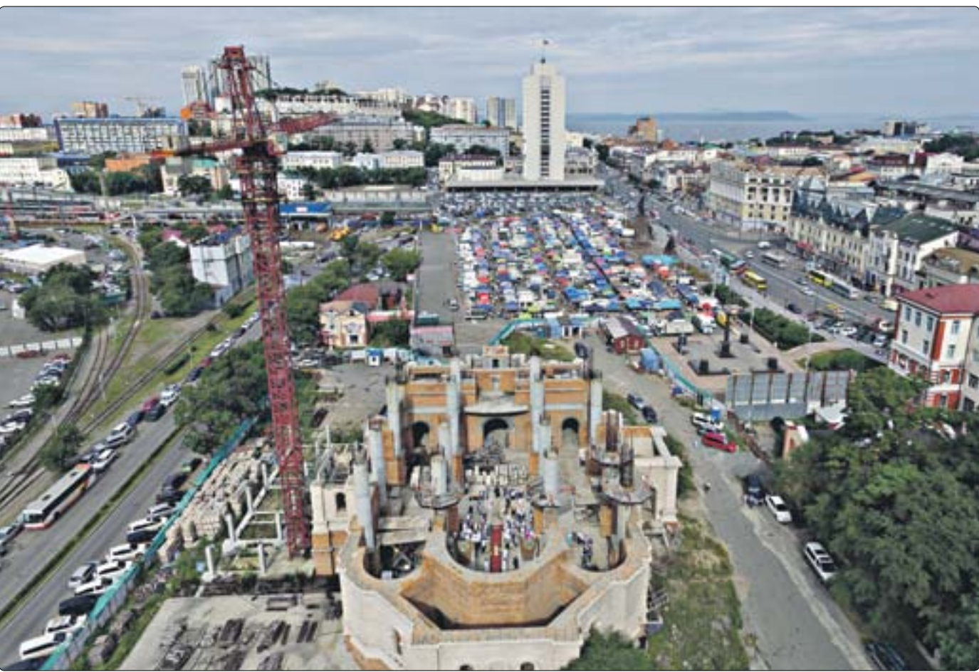
Панорама. Молебен в строящемся храме. Август 2016 г.
